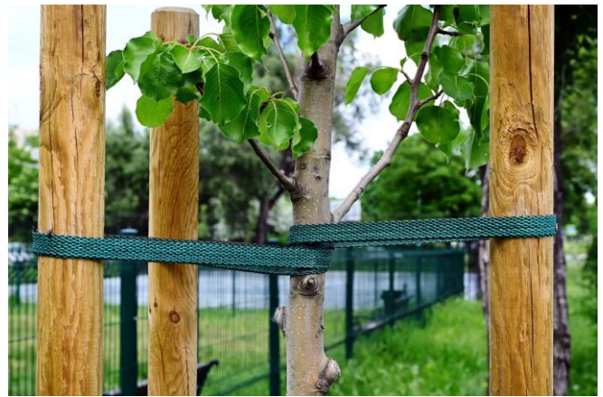
Figura 2. Los sistemas de apuntalamiento o de poner estacas pueden dañar el tronco si no se ajustan a medida que el árbol crece.
