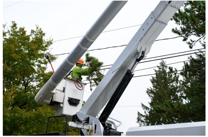
Figura 4. Sólo arboricultores calificados en la restauración de líneas eléctricas, pueden trabajar en árboles cerca de las líneas eléctricas.
