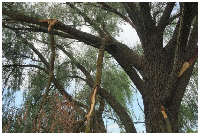
Figura 3. Los árboles dañados en lugares públicos y en áreas muy transitadas, como parqueaderos, requieren de atención inmediata. Las ramas quebradas que cuelgan son peligrosas para carros y peatones.
