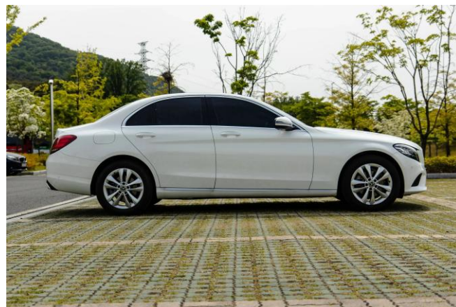
Figure 4. Los adoquines permeables permiten que el agua se filtre en el suelo, en lugar de escurrirse.
